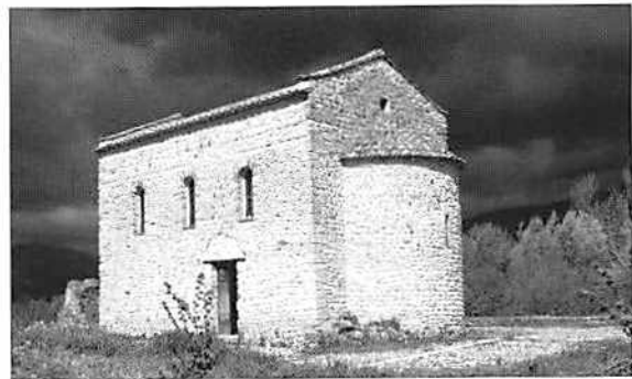
Fig. 3. La chiesa dopo il restauro. Veduta da sud-est.
