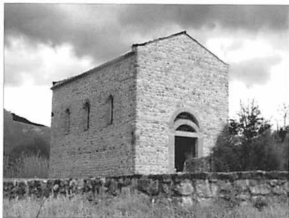
Fig. 5. La chiesa dopo il restauro. Veduta da nord-ovest.
