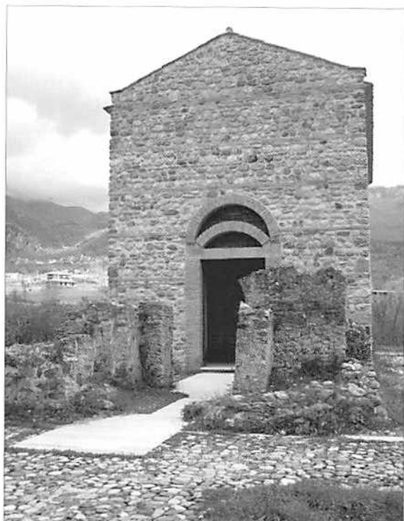
Fig. 6. La facciata con resti di un'altra costruzione antistante.
