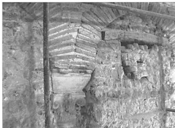
Sotto. Fig. 6. Bifora prima del restauro - lato nord.
