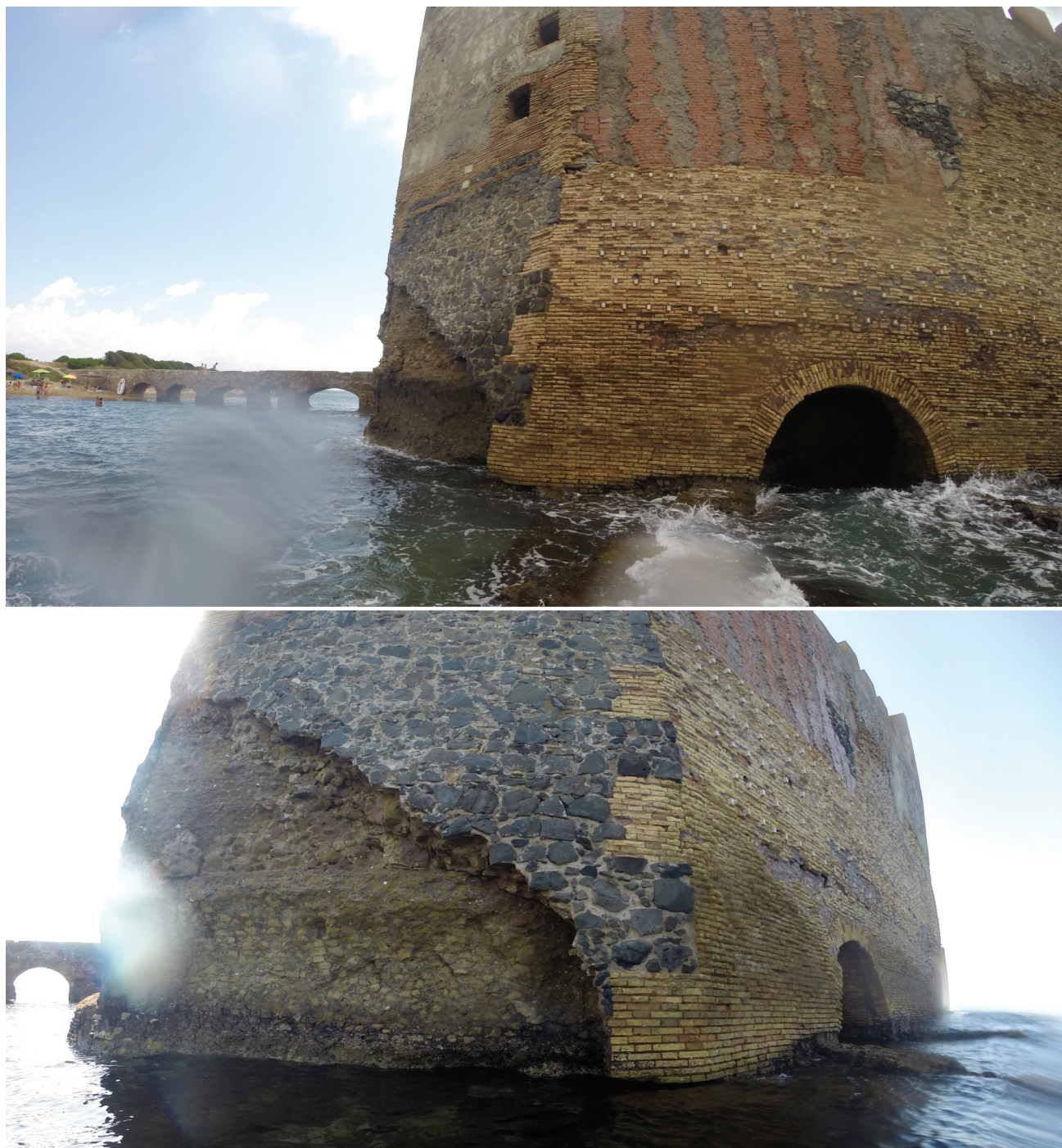
Fig. 3 – Torre Astura. Vedute da ovest dei restauri realizzati con basoli di riuso (Foto dell'Autore).
