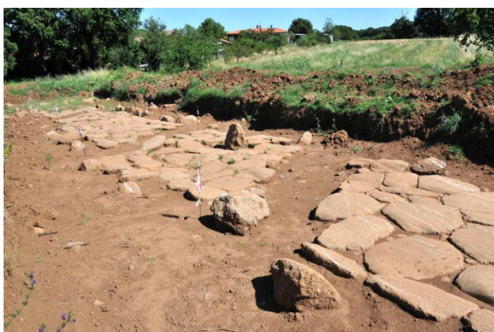
Fig. 12. Vetralla (Vt), Loc. "Campo Giordano". Resti dell'antica Via Cassia. Particolare dei guasti provocati dai lavori agricoli, da Sud.
