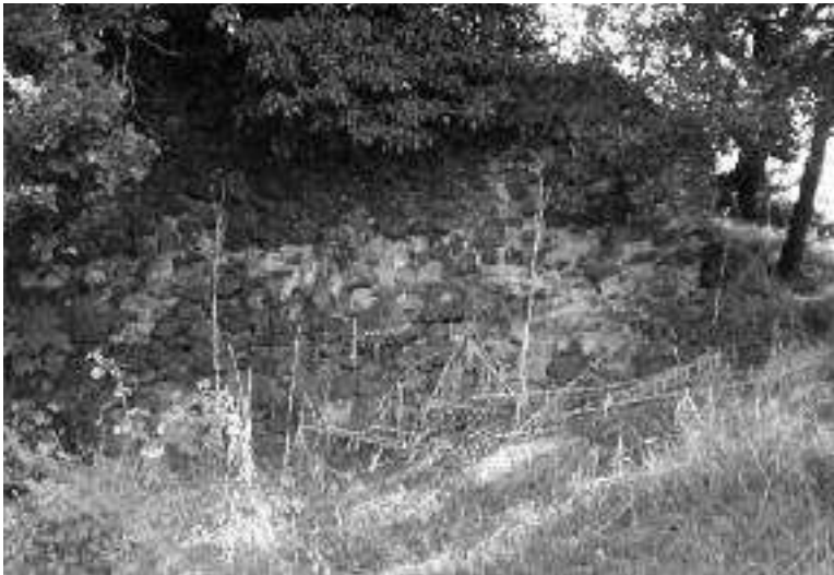
Fig. 6. Località Muracce, Sostruzione della villa romana (foto Ceci).
